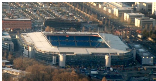
Ullevål stadium har store energilager i fjell, såkalte jordtermoser.
