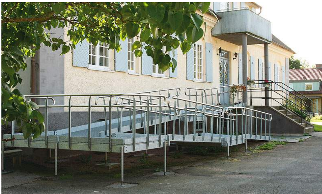
Figur 125_ Høy terskel på 1.etasje vanskeliggjør etablering av publikumsrettede funksjoner med direkte kontakt til byrommet. Rampene krever mye plass og er et nødvendig onde for å sikre universell utformete adkomster til bebyggelsen.
